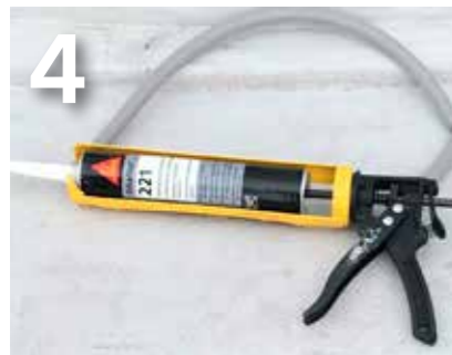
4 Ggf. Fuge mit PE Schnur verfüllen, mit Sikaflex® PRO-3 verschließen und mittels Fugengleitband entkoppeln.
