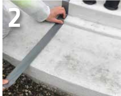
2 Abzudichtenden Bereich ggf. mit Klebeband abgrenzen.
