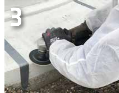
3 Untergrundvorbereitung und Reinigung mit geeigneten Maßnahmen. Siehe S. 9/16
