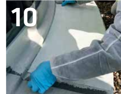
10 Vlies blasen- und faltenfrei einlaminiieren.
