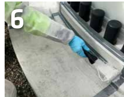
6 Grundierung gem. Verlegeanleitung Sikalastic vornehmen.
