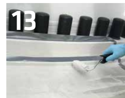
13 Fugenbereich mit Steinband PE Oberfläche abkleben. Rollvorlage mind. 1,0 kg/m 2
