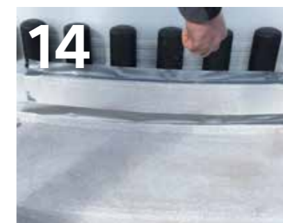
14 Einwurf Quarzsand 0,7-1,2 mm frisch in frisch, Korn an Korn. Klebeband Fugenbereich unmittelbar danach entfernen.
