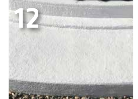
12 Nun ist die Abdichtung funktionsbereit.
